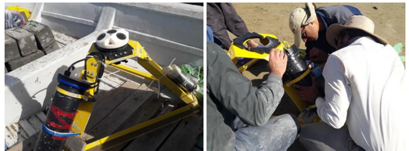
آماده سازی دستگاه AWAC جهت استقرار در کف دریا مطالعه جریان در دوره ی زمانی ۳۰ روزه در محل احداث آب شیرین کن کوه مبارک
